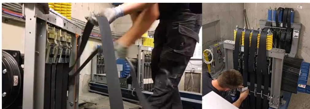
Figura 15. Instalación de las cintas planas, recubiertas con capa de poliuretano flexible 2 .
