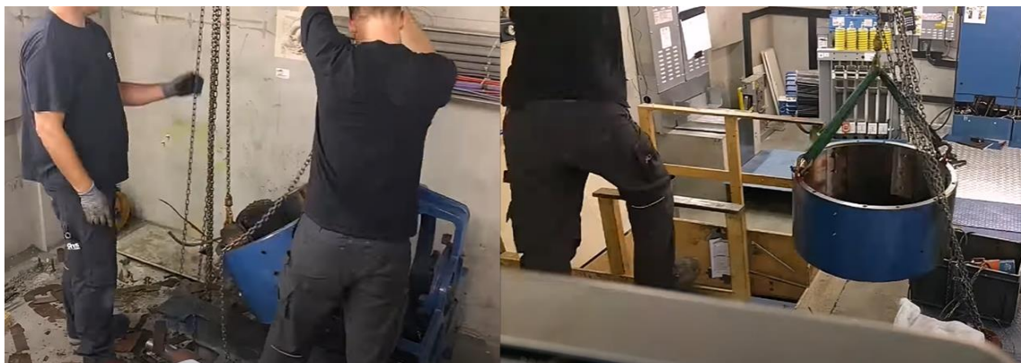
Figura 10. Remoción de los motores y otros elementos del cuarto de máquinas 2 .
