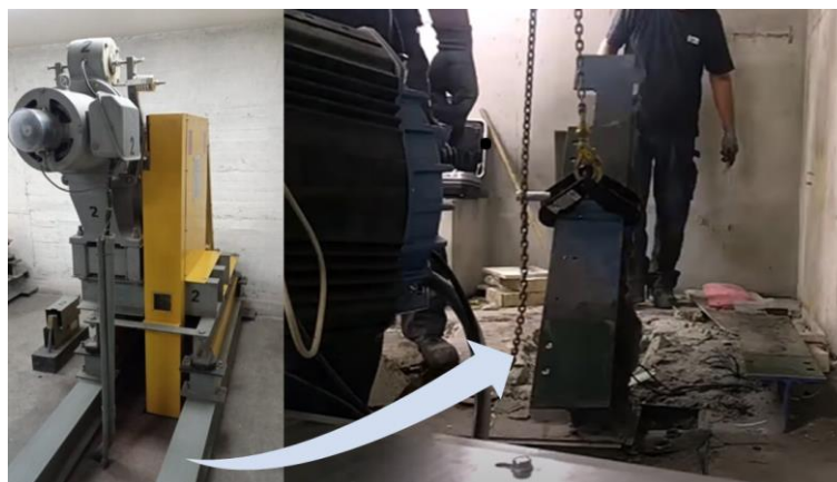
Figura 11. Retiro de los pedestales de acero de los antiguos motores 2 .
