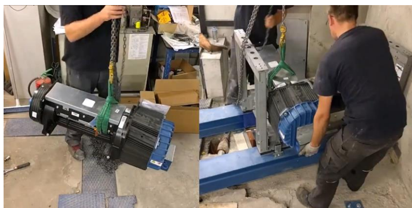
Figura 14. Instalación de motores de imán permanente (50% más pequeños que los actuales) 2 .
